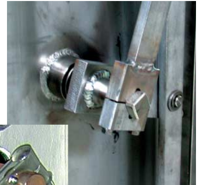
Bild 11: Aus der Praxis von Qualitätsarbeit, geeignet für besondere Einsätze. Der Übergang vom Motor auf die Klappenachse erfolgt bei Lucoma-Antrieben (Bild oben) via Vierkant und perfekte, regelmässige Schweissnaht. Als Gegenbeispiel eine Klappe (gesehen an der Intertunnel 2001, Basel) lediglich mit Klemmung und Schweisspunkten, also sog. Taubensch...
